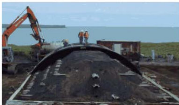
Figura 4.50 Las reacciones de óxido-reducción se utilizan en la restauración de suelos contaminados con hidrocarburos, plaguicidas o solventes.
